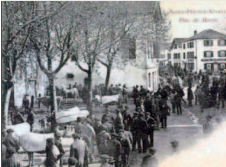
Behi eta idiak laborantzako eta garraiorako tresna bizidunak
